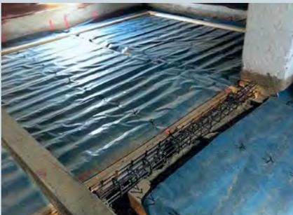
Dachboden: Sanierung Holzrippen-Verbunddecke
